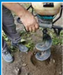
Izrada temeljne jame
