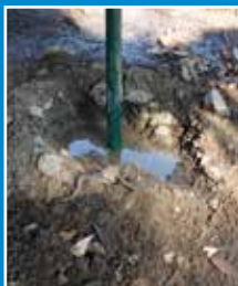
Naknadno vlaženje stvrdnutog materijala
