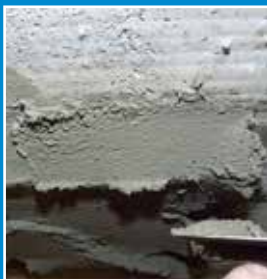
Obrada reparaturnog morta
